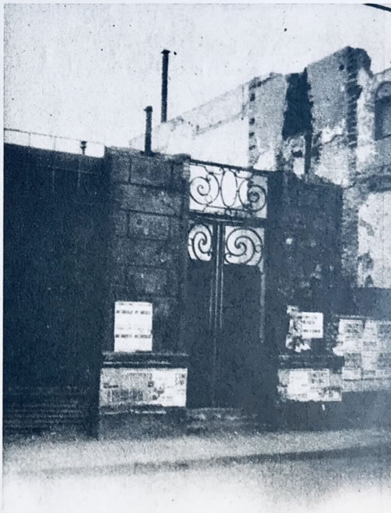
Restos de la casa —que era de altos— donde vivió Juan Luis Nougues durante su gobierno (foto de 1966, antes de la demolición total).
